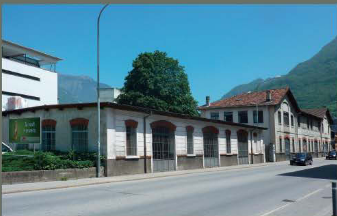
L'ex arsenale di Bellinzona costruito per il deposito dei cannoni, come si intuisce dalle grandi porte che si aprono su Viale Portone.
