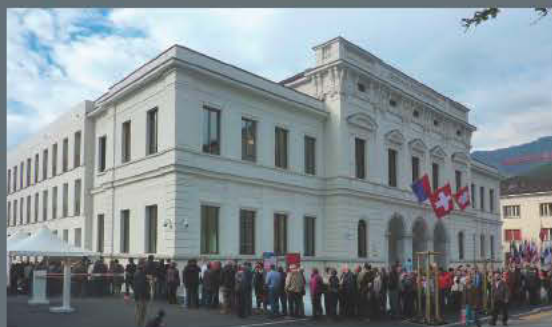
Da Scuola cantonale di commercio a nuova sede del Tribunale federale penale, inaugurata il 26 ottobre 2013 a Bellinzona.
