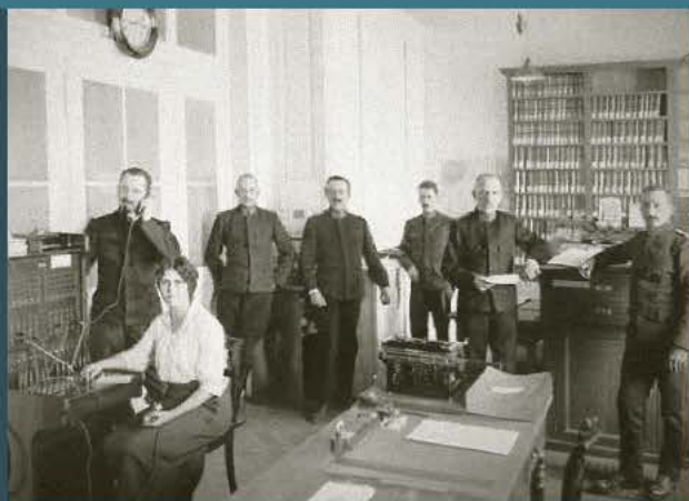
Un centralino militarizzato nel 1915 (foto Memoriav).
