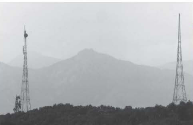
Le antenne, alte ben 120 metri, a sostegno del cavo irradiante delle onde medie sul Monte Ceneri, erette nel 1933.
