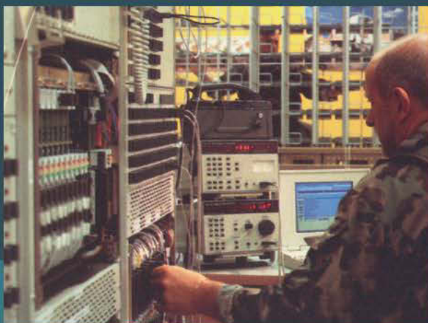
Centrale di comando del ventunesimo secolo.
